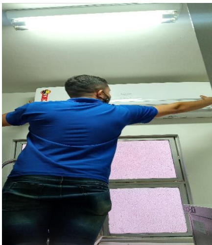
Figura 1 Limpeza do ar condicionado
