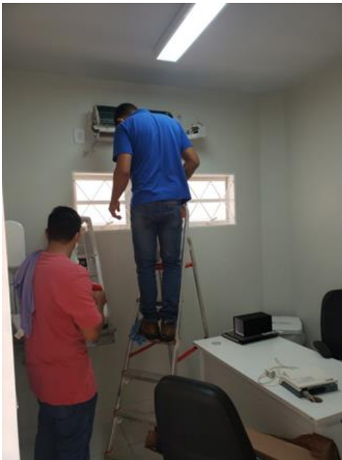
Figura 1 . Manutenção Ar condicionado
