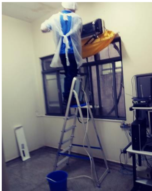
Figura 9. Manutenção ares condicionados
