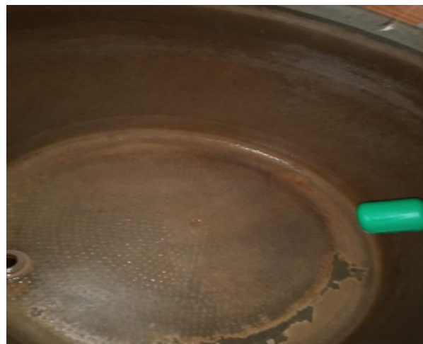
Figura 2 Limpeza Caixa d'Água
