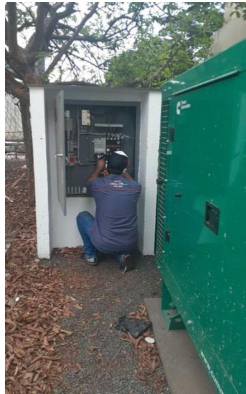
Figura 8. Manutenção Preventiva Gerador
